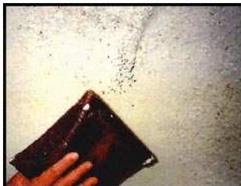
El acabado en los productos **STUCAL** exteriores puede ser *pulido con llana o fratasado*.
